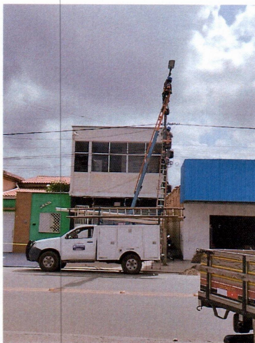
Figura 05: equipe em campo realizando substituições necessárias de Lâmpadas, cabo elétrico, conector, reator, arruela, braços com caminhonete adaptada.
