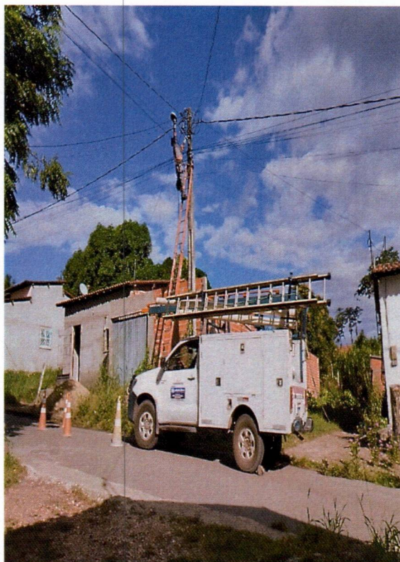
Figura 09: equipe em campo realizando substituições necessárias de Lâmpadas, cabo elétrico, conector, reator, arruela, braços com caminhonete adaptada.
