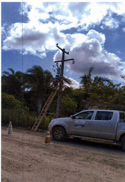
Figura 08: equipe em campo realizando substituições necessárias de Lâmpadas, cabo elétrico, conector, reator, arruela, braços com caminhonete adaptada.
