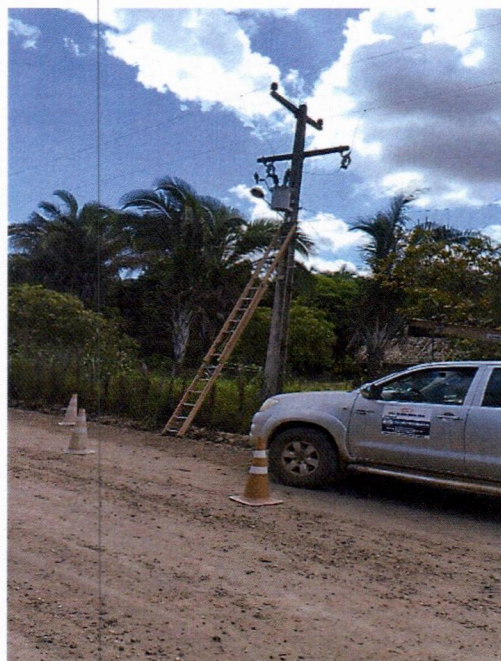
Figura 12: equipe em campo realizando substituições necessárias de Lâmpadas, cabo elétrico, conector, reator, arruela, braços com caminhonete adaptada.
