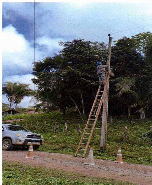
Figura 03: equipe em campo realizando substituições necessárias de Lâmpadas, cabo elétrico, conector, reator, arruela, braços com caminhonete adaptada.
