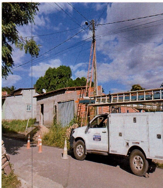
Figura 04: equipe em campo realizando substituições necessárias de Lâmpadas, cabo elétrico, conector, reator, arruela, braços com caminhonete adaptada.
