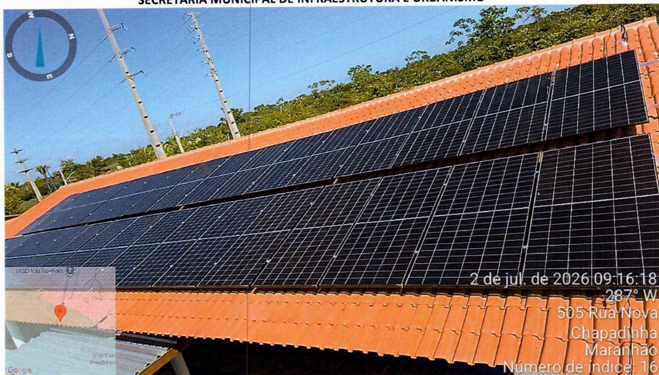
Imagem 04 – Instalações de painéis na escola U. E ANA FORTES DE MENESES
