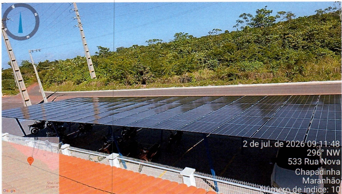
Imagem 01 – Instalações de painéis na escola U.E ANA FORTES DE MENESES
