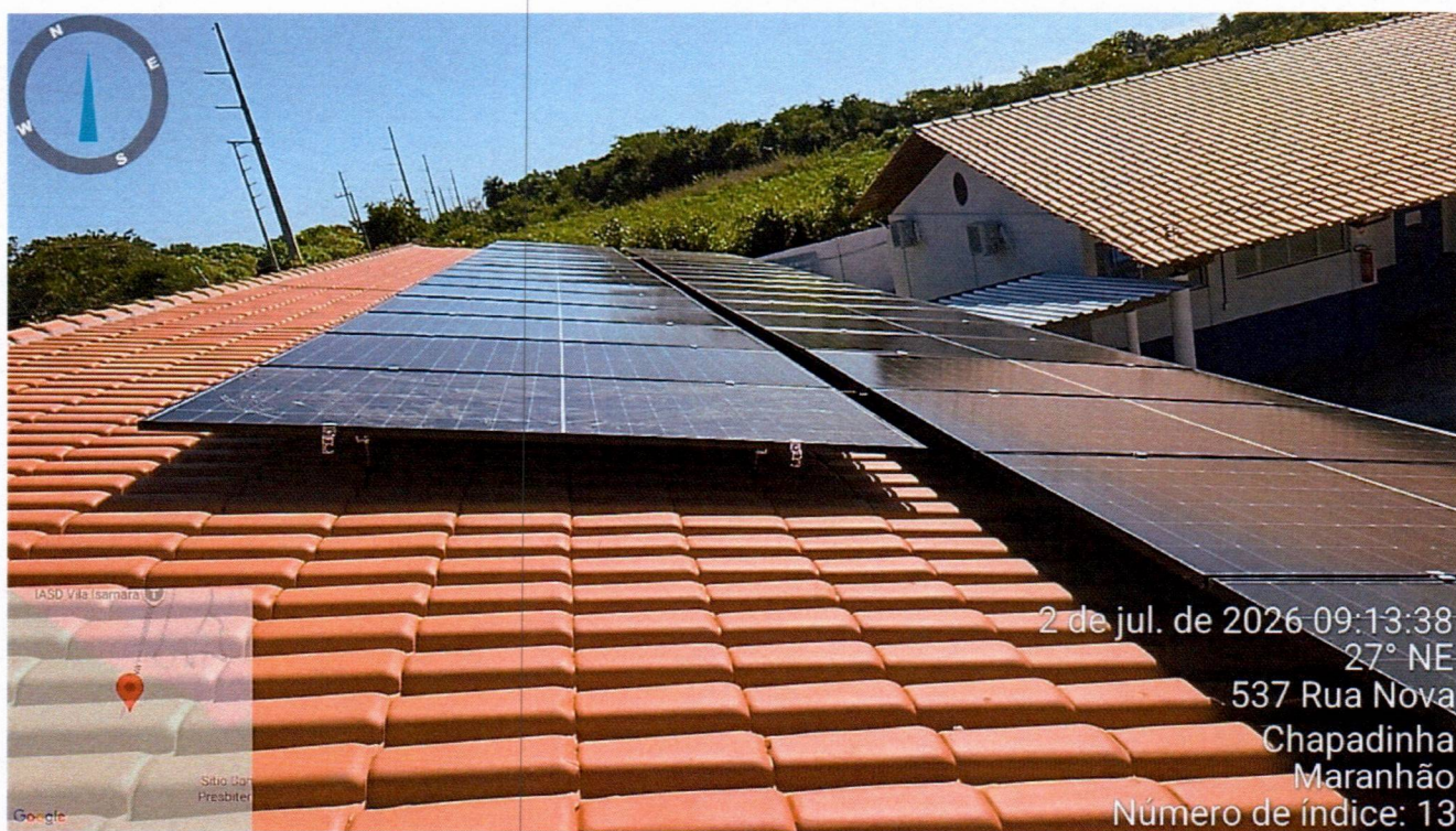
Imagem 03 – Instalações de painéis na escola U. E ANA FORTES DE MENESES
