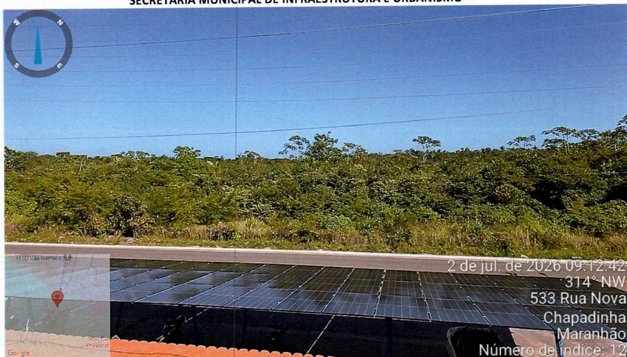
Imagem 02 – Instalações de painéis na escola U. E ANA FORTES DE MENESES
