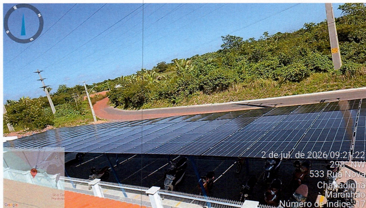
Imagem 05 – Instalações de painéis na escola U. E ANA FORTES DE MENESES
