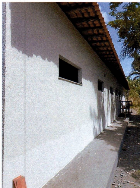
Imagem 3 – Execução da pintura externa do prédio.
