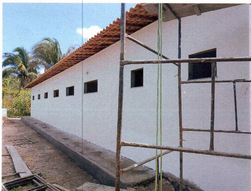
Imagem 4 – Execução da pintura externa do prédio.
