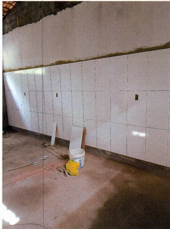
Imagem 9 – Execução assentamento de revestimento cerâmico da cozinha.
