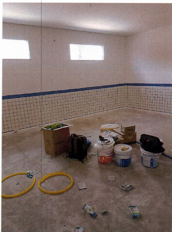
Imagem 7 – Execução do revestimento 10x10cm e pintura das salas de aula.
