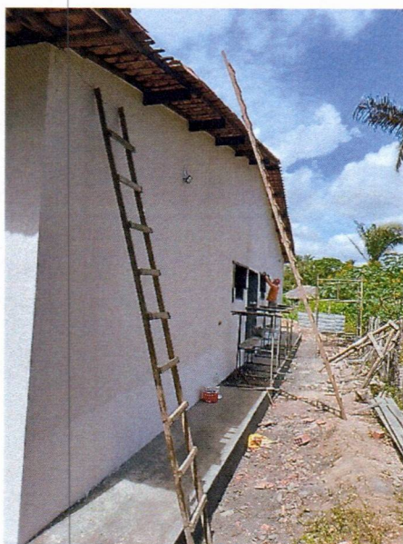
Imagem 2 – Execução da pintura externa do prédio.
