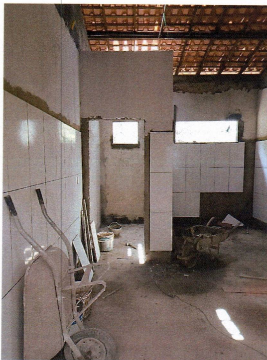
Imagem 8 – Execução assentamento de revestimento cerâmico da cozinha.
