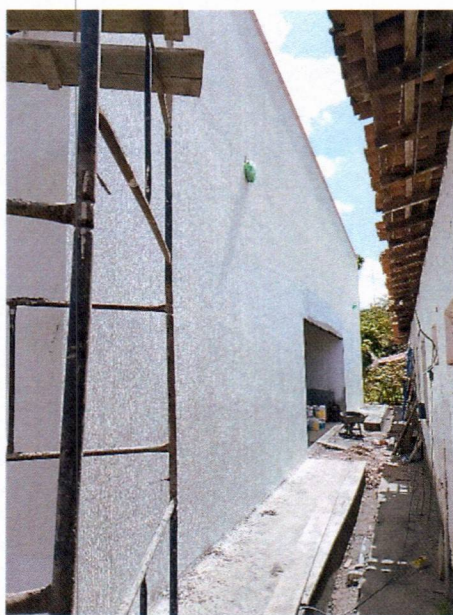
Imagem 1 – Execução da pintura externa do prédio.
