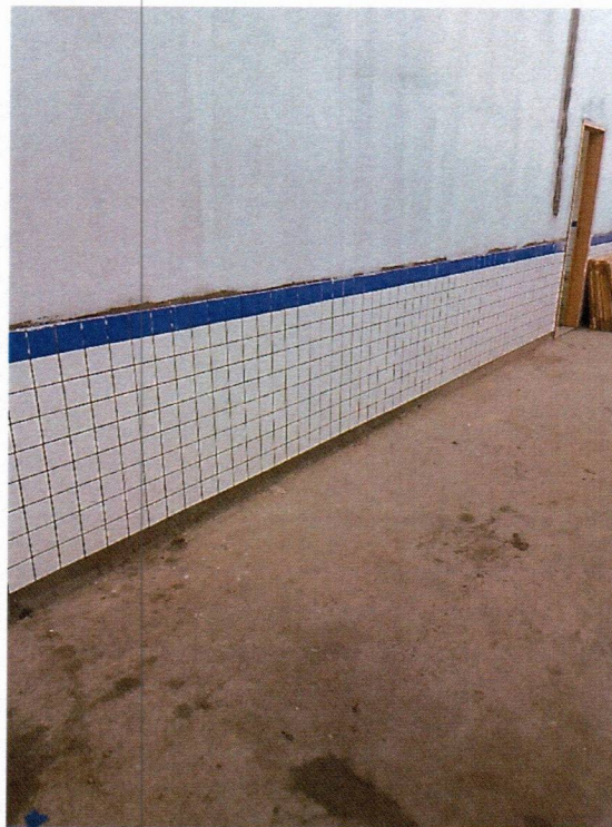
Imagem 6 – Execução do revestimento 10x10cm no pátio da escola.
