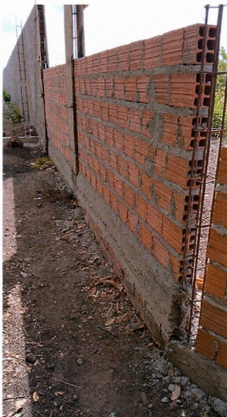
Imagem 09 – Execução de construção de muro
