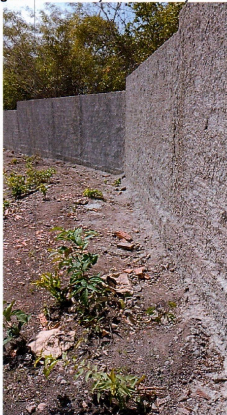
Imagem 11 – Execução de construção de muro
