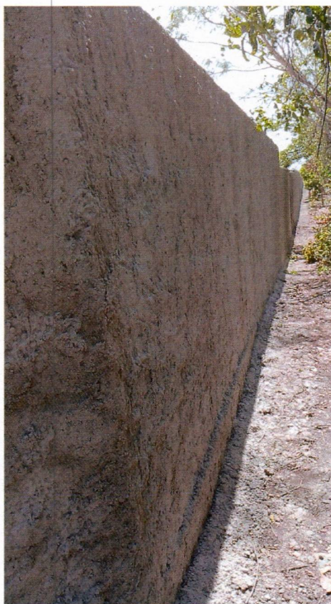
Imagem 13 – Execução de construção de muro
