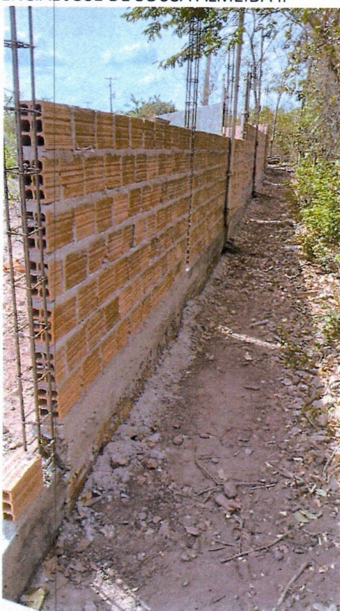
Imagem 01 – Execução de construção de muro
