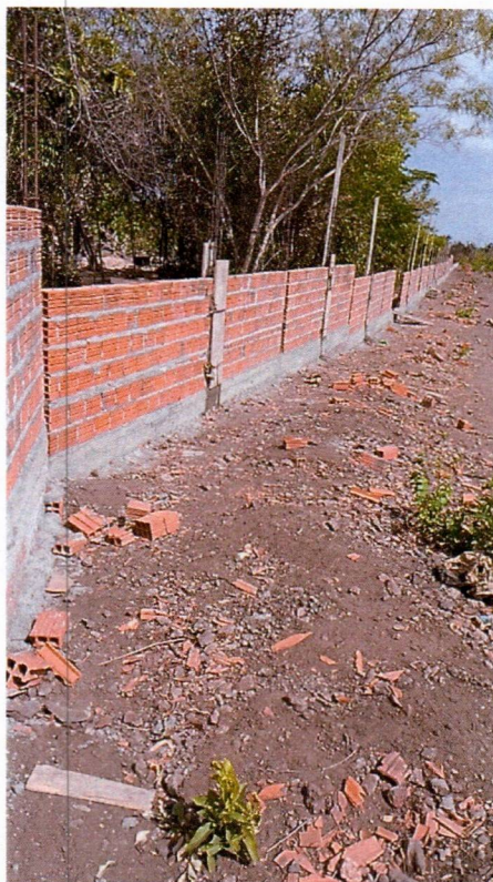
Imagem 06 – Execução de construção de muro
