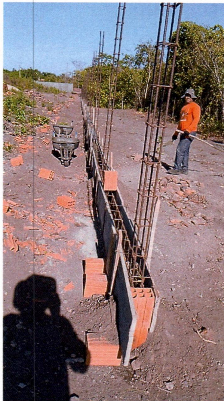
Imagem 04 – Execução de construção de muro
