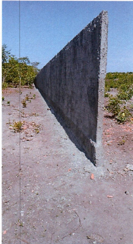
Imagem 10 – Execução de construção de muro
