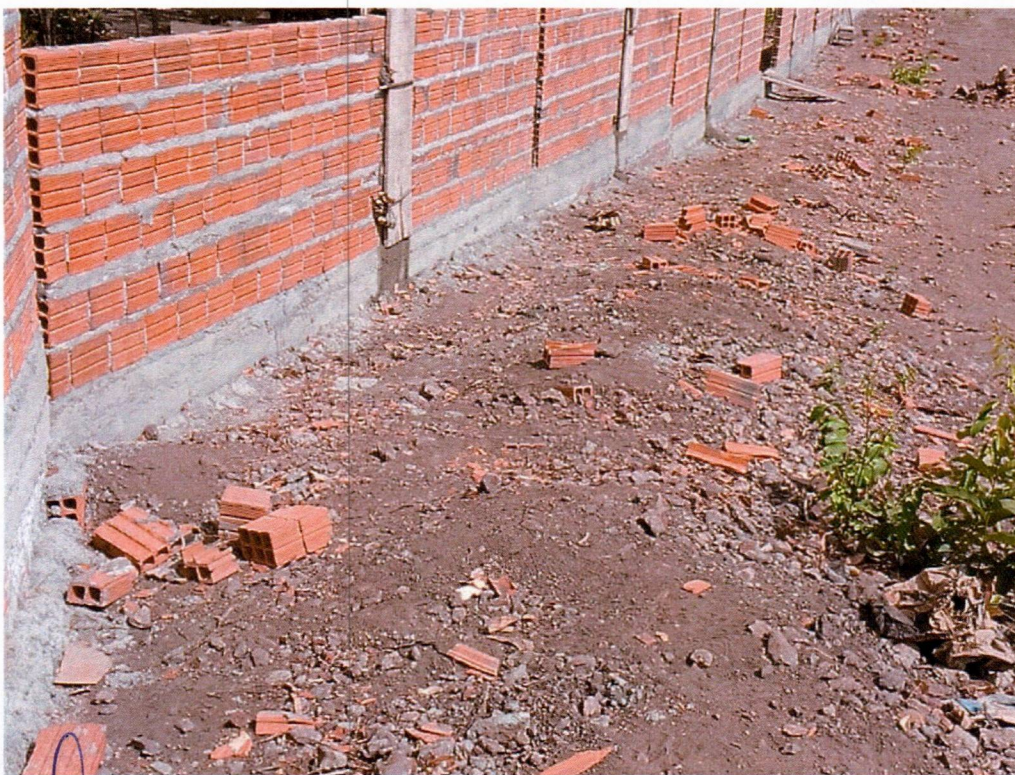
Imagem 07 – Execução de construção de muro
