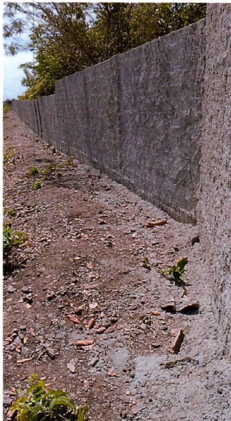
Imagem 12 – Execução de construção de muro
