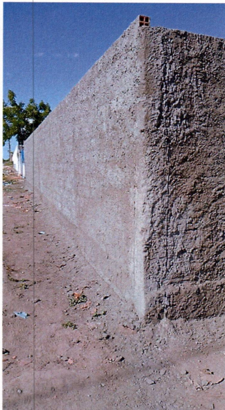
Imagem 14 – Execução de construção de muro
