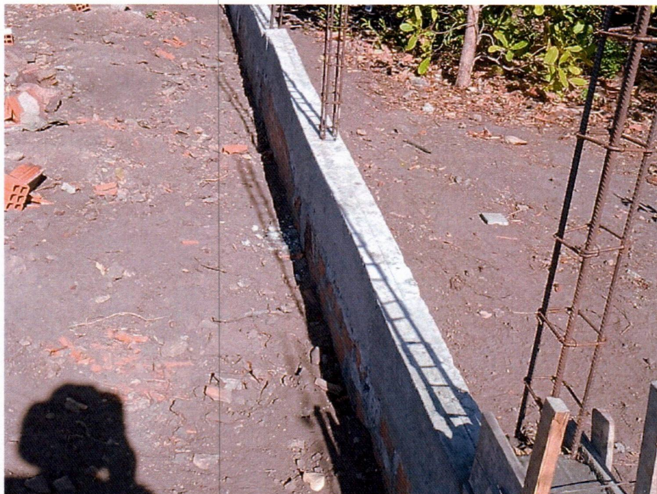
Imagem 02 – Execução de construção de muro
