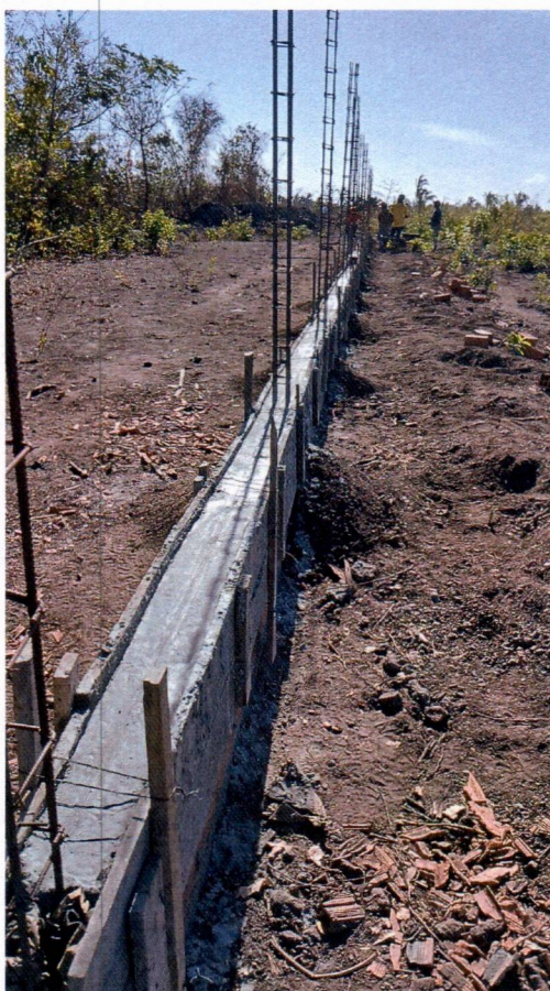
Imagem 03 – Execução de construção de muro
