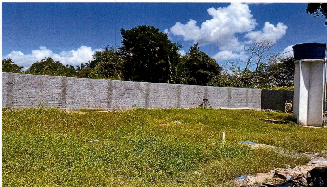
Imagem 03 – Execução de construção de muro
