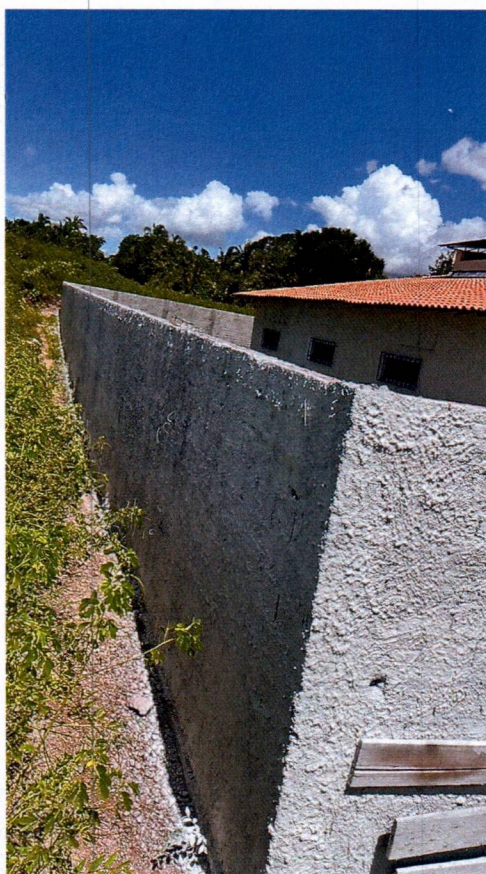
Imagem 01 – Execução de construção de muro
