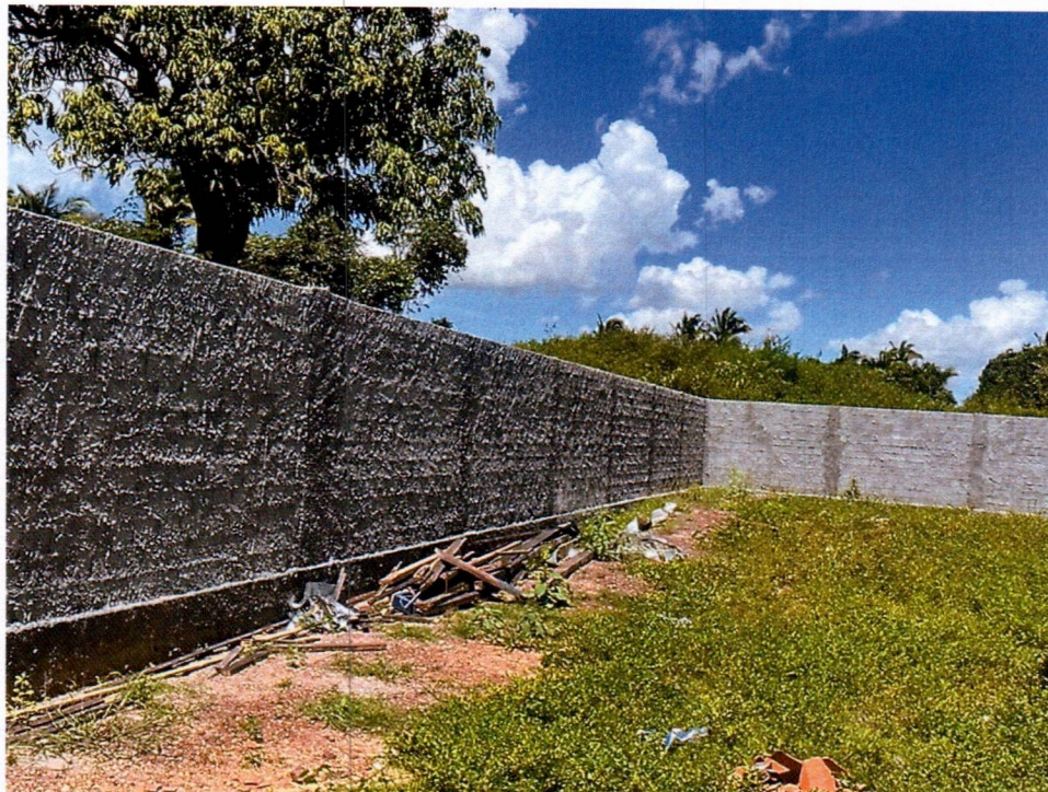
Imagem 02 – Execução de construção de muro
