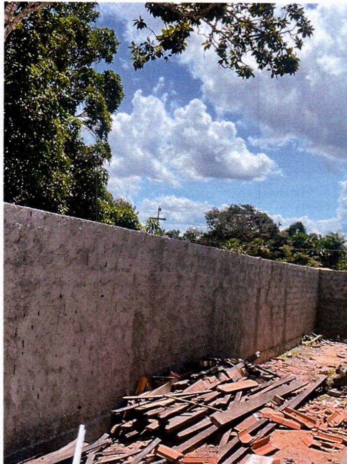
Imagem 06 – Execução de construção de muro
