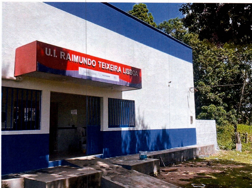
Imagem 08 – Execução de construção de muro
