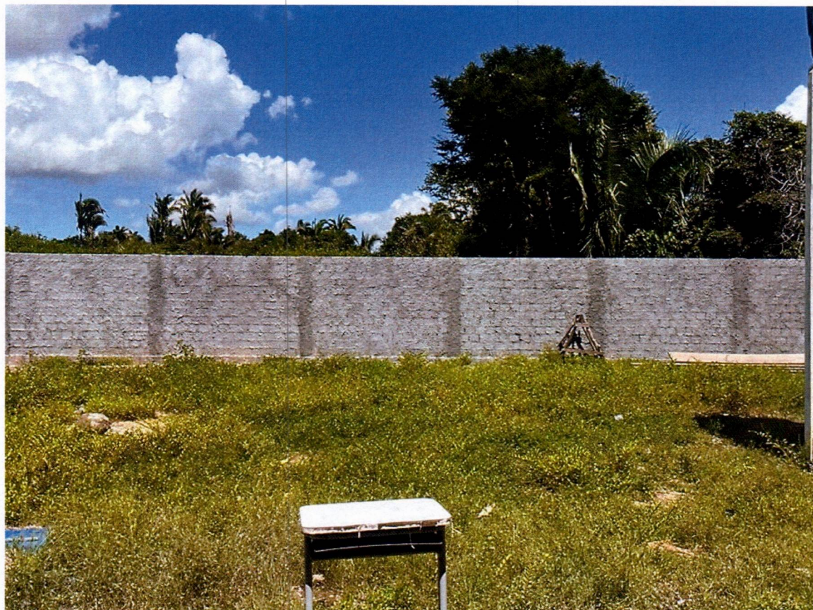
Imagem 05 – Execução de construção de muro
