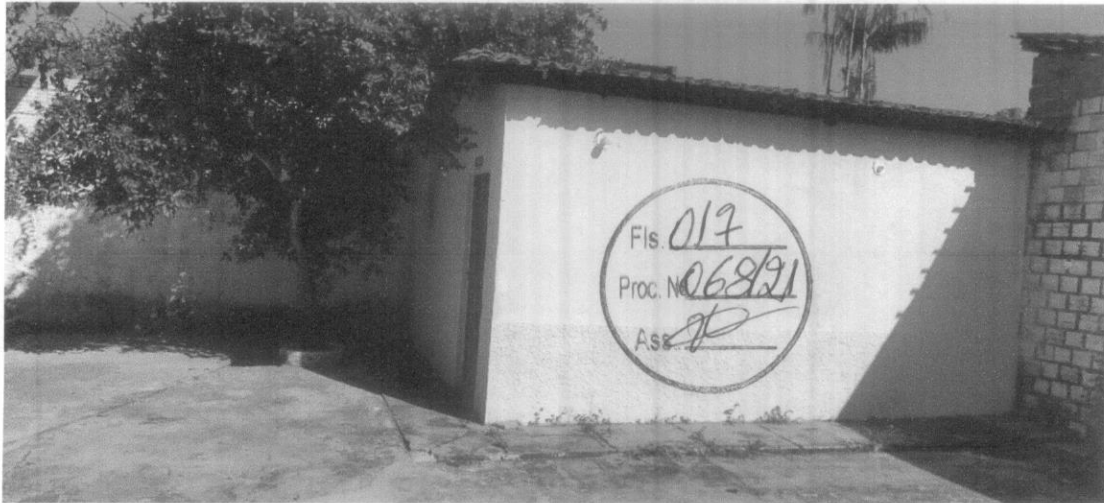
Depósito Fonte: Acervo Técnico (2021)
