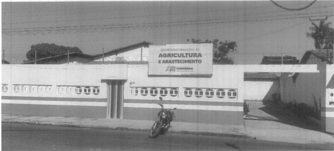
Fachada Fonte: Acervo Técnico (2021)
