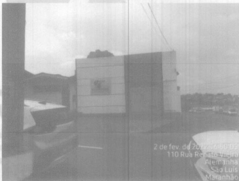
Vista Ampliada da Fachada.
