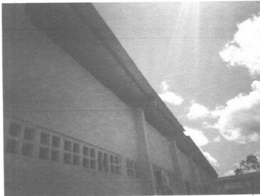
Imagem 10 – vista lateral da cobertura metálica do ginásio.
