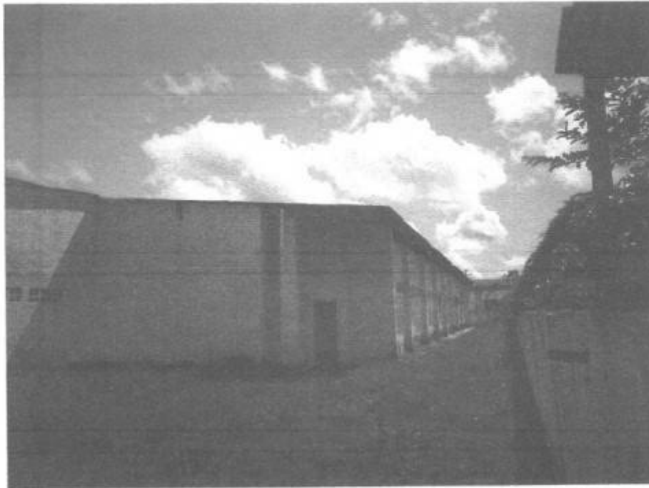
Imagem 09 – vista da cobertura metálica na área externa do ginásio.
