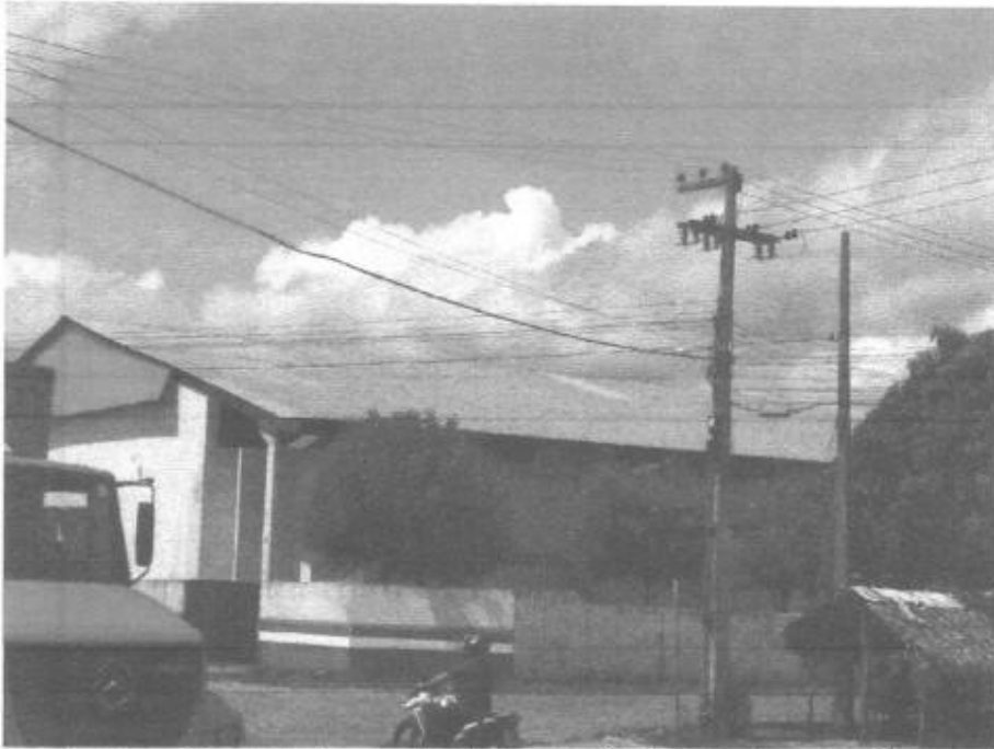
Imagem 13 – vista dos pontos de inclinação da cobertura metálica.
