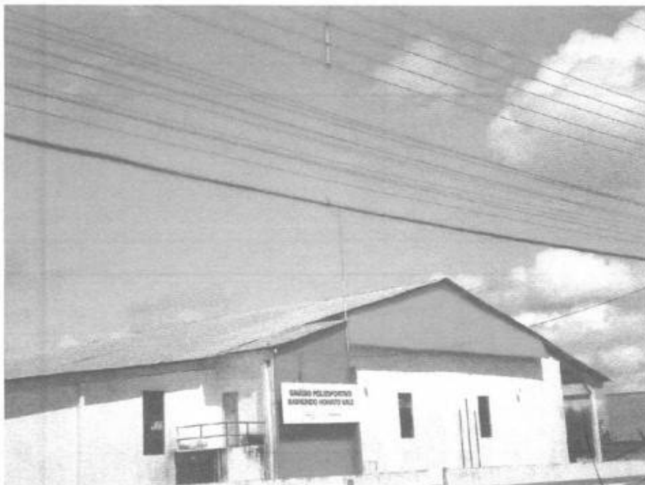
Imagem 14 – vista dos pontos de inclinação da cobertura metálica.
