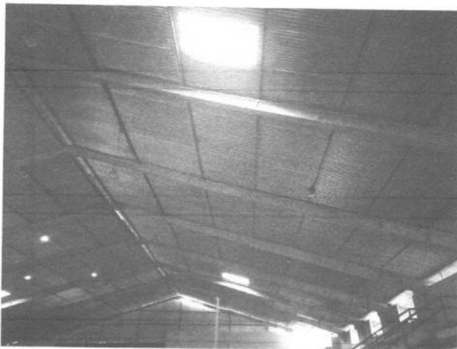
Imagem 05 – vista dos pontos de iluminação natural da cobertura.
