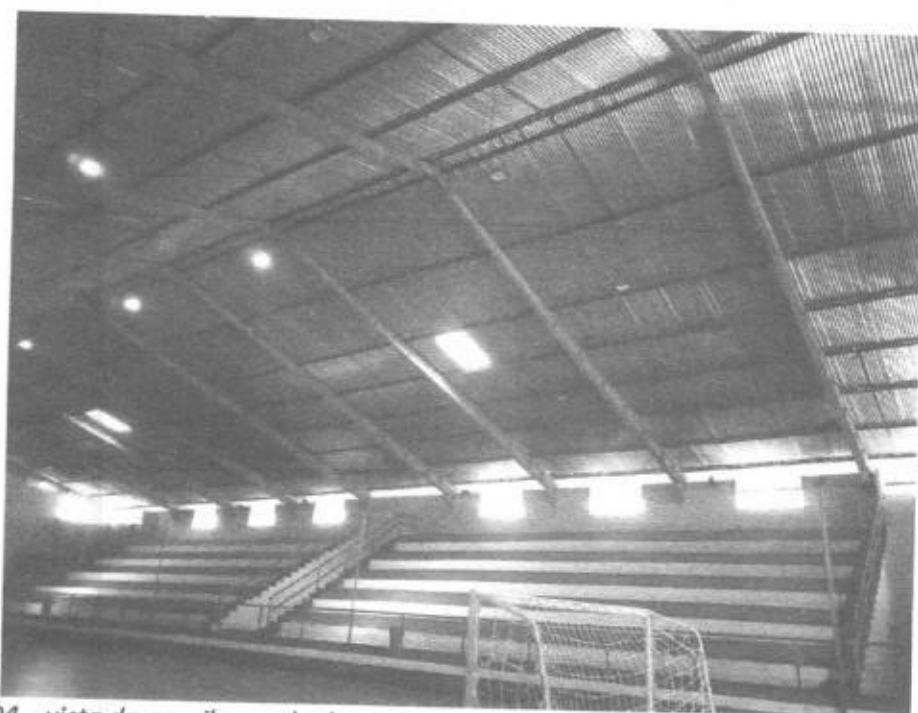
Imagem 03 – área interna do ginásio – cobertura em chapa metálica.
