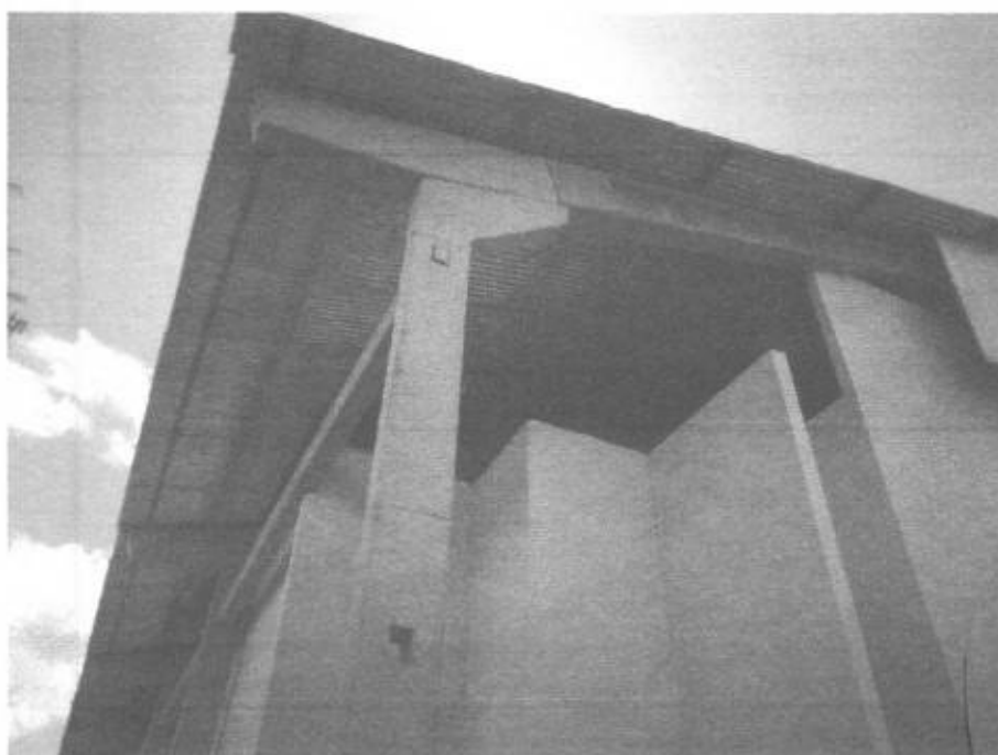
Imagem 16 – estrutura pré-moldada de concreto, cobertura em chapa metálica.
