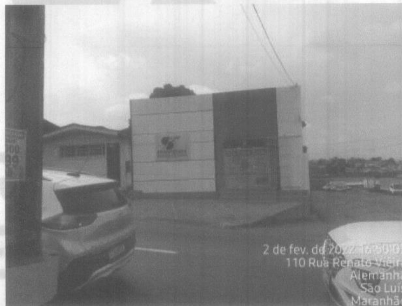
Vista Ampliada da Fachada.
