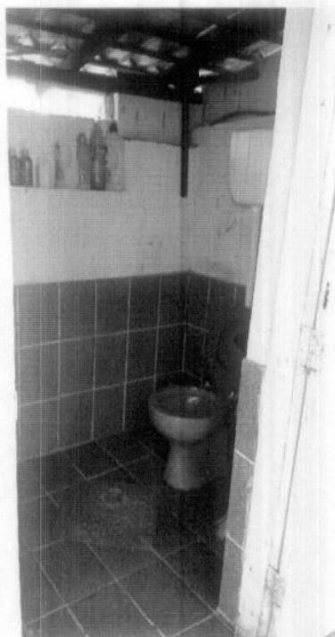
Banheiro 2 Fonte: Acervo Técnico (2021)
