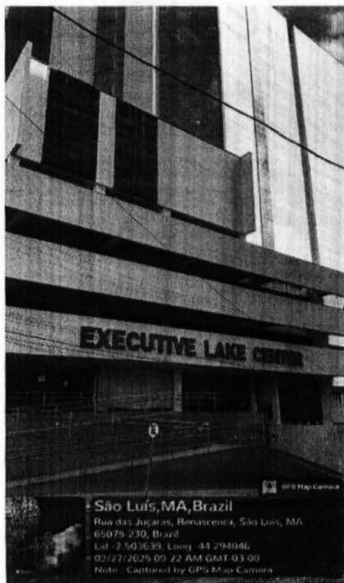
FOTO DA FACHADA FRONTAL DO PREDIO COM GEOREFERENCIAMENTO
